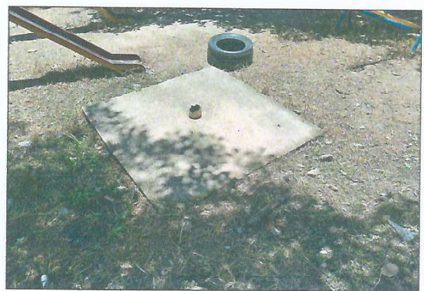
Foto 2: La fosa séptica a mejorar.
